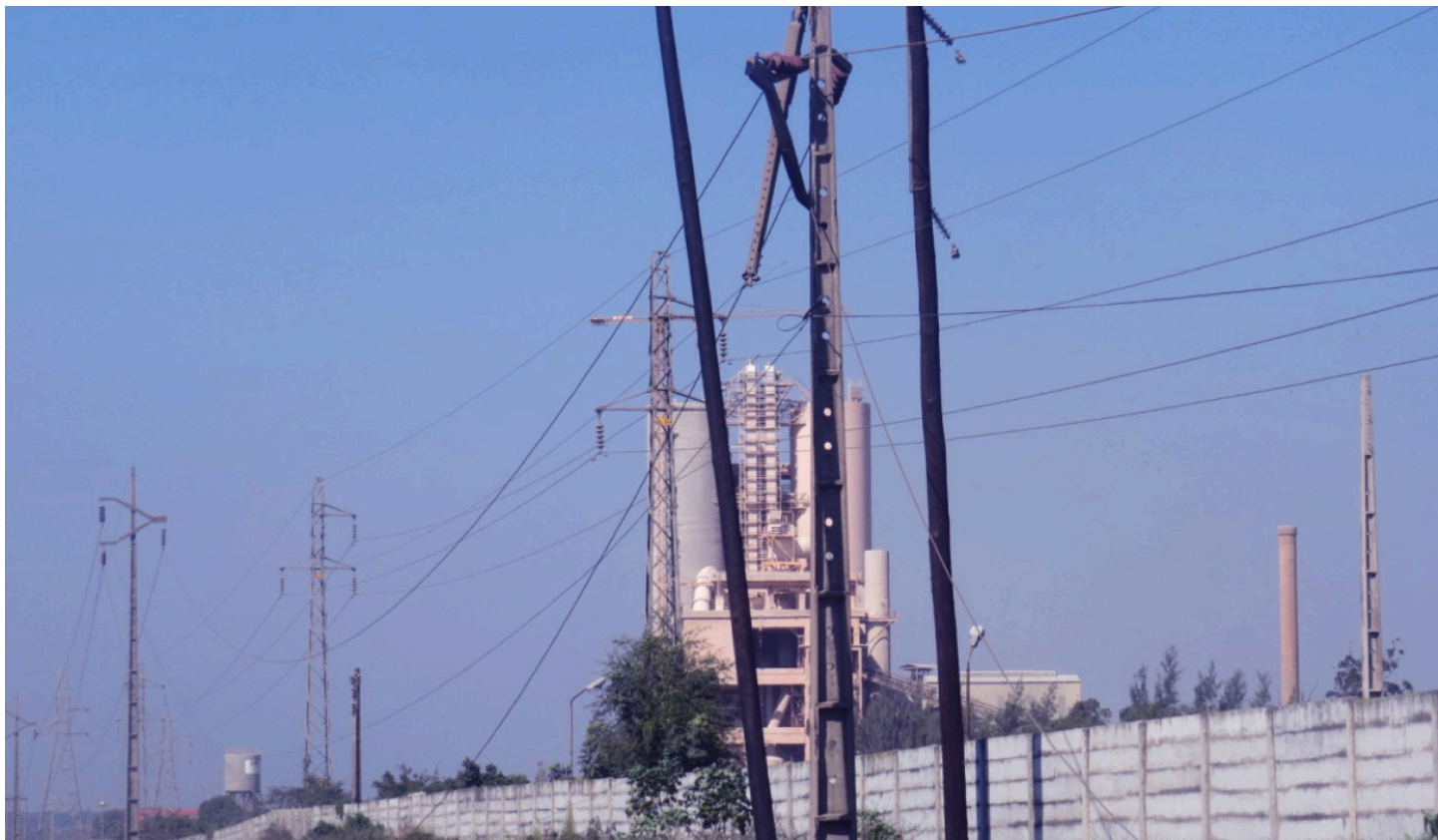
Linhas de corrente eléctrica de alta tensão sobre os tanques de armazenamento de combustíveis representam grave problema de segurança
