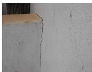
Fig. 3 Racha na Parede – Cuamba
