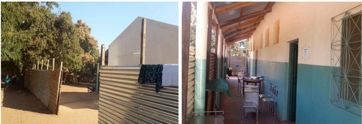
Fig. 4: Vedação que separa o lado das salas de aulas transformadas em hospital e o recinto escolar
