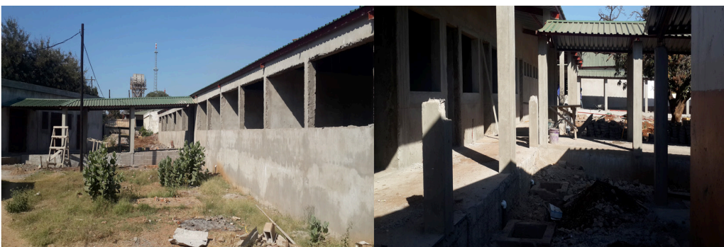
Fig. 3: Centro de Saúde de Cuamba ainda em obras
