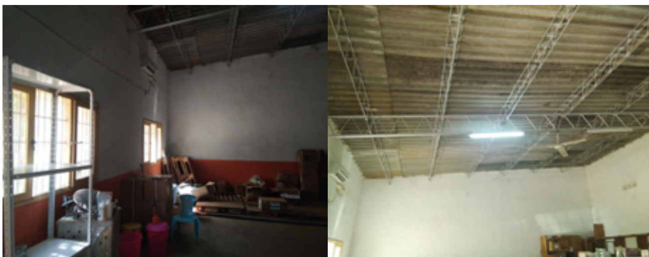
Foto 5: Depósito Distrital de Medicamentos de Cuamba
