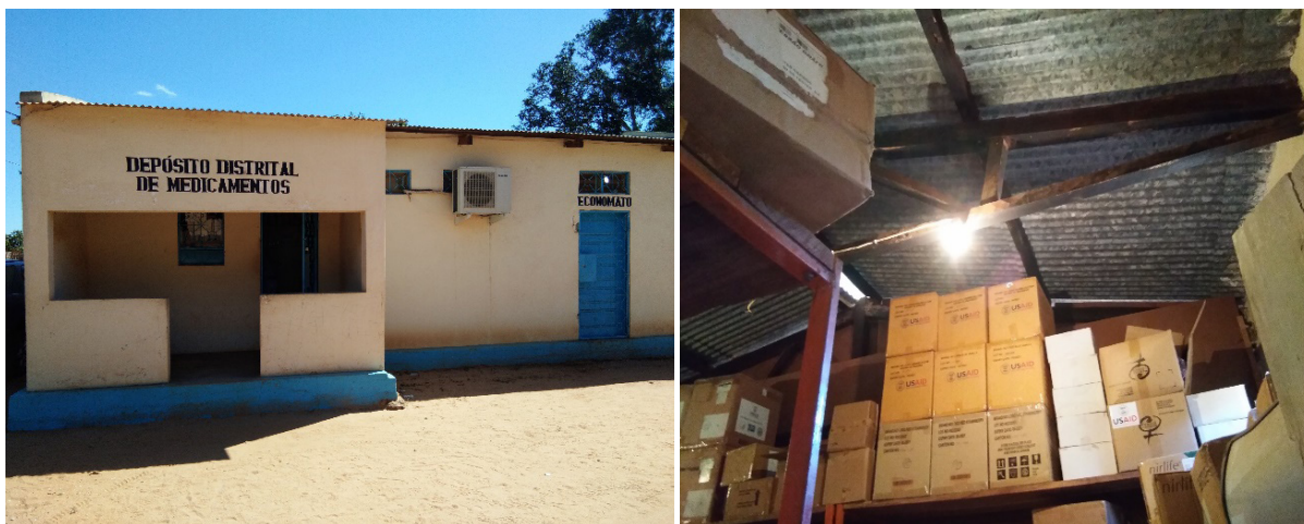
Foto. 2 Depósito de medicamentos, medicamentos expostos ao calor do sol, depósito sem sistema de segurança.
