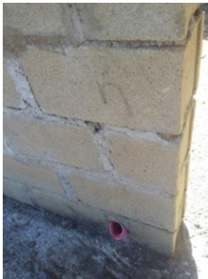
Figura 2.6. Havia evidências de danos e rupturas ao nível das obras de canalização.
