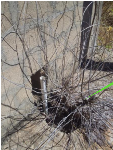
Figura 2.5. A laje da varanda foi extensivamente danificada devido às fissuras provocadas pelo crescimento de raízes da vegetação.
