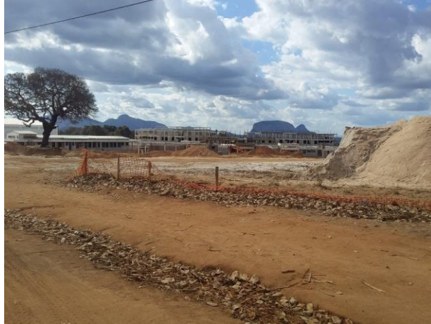
Figura 1.1. O nível de construção encontra-se na laje de cobertura, telhado, instalação de condutas eléctricas e mecânicas e nas obras externas.
