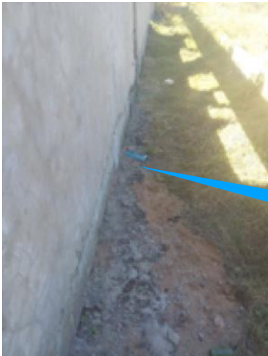
Figura 2.10. Danos nas obras de canalização. Havia evidências de danos e rupturas ao nível das obras de canalização. Todas as obras de canalização devem ser tratadas como novas obras no contrato do novo Empreiteiro.
