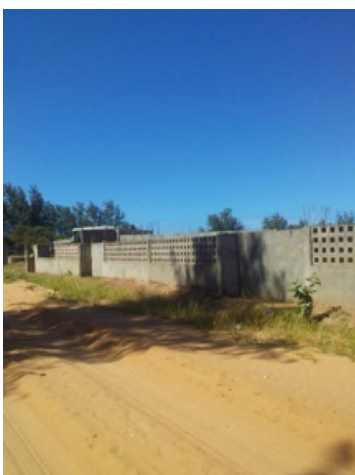
Figura 2.12. O muro de vedação estimava-se em 5%, com 25m do muro já construído.
