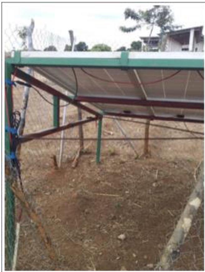
Figura 3.2. Elementos estruturais para os suportes de painéis solares: Todos os elementos estruturais de aço devem ser adequadamente preparados e pintados mediante as especificações.
