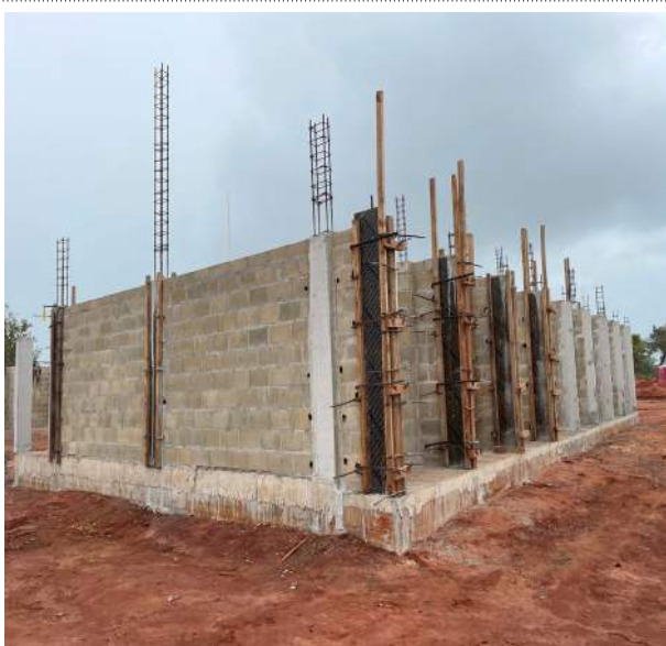
Casa em construção
