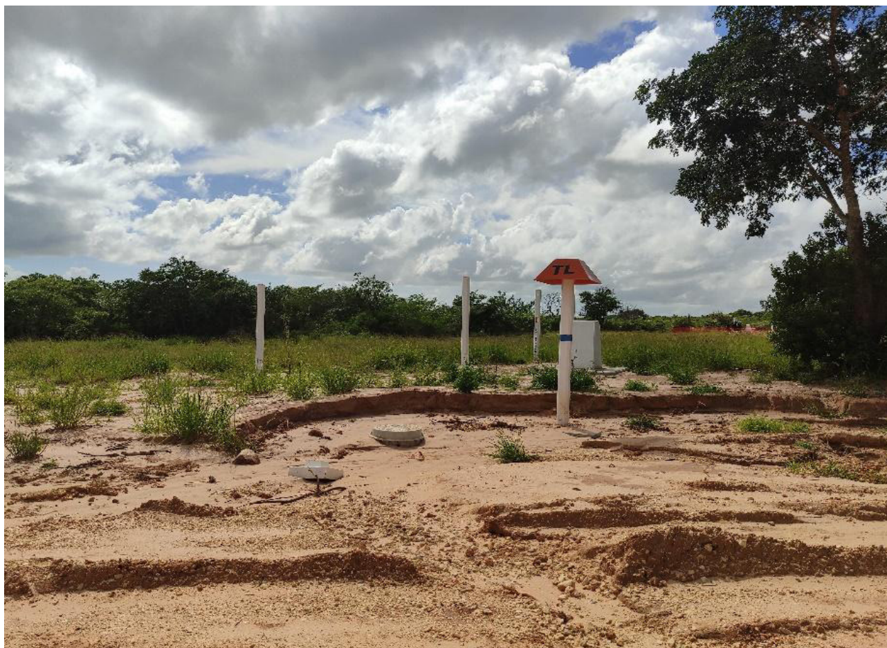
Figura 6: Sinal de passagem do gasoduto em Mabime. 31 de Janeiro 2023
