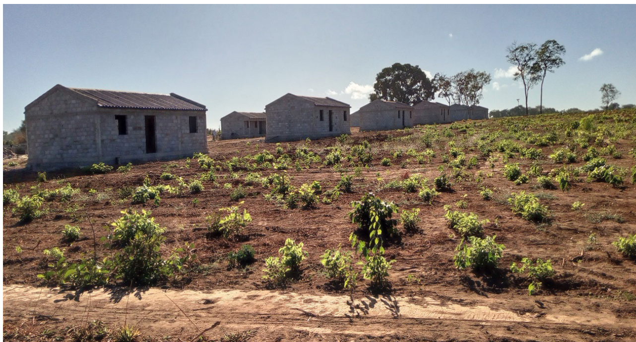
Figura 3: Casas de Reassentamento da comunidade de Mwichi – aprovadas e em construção
